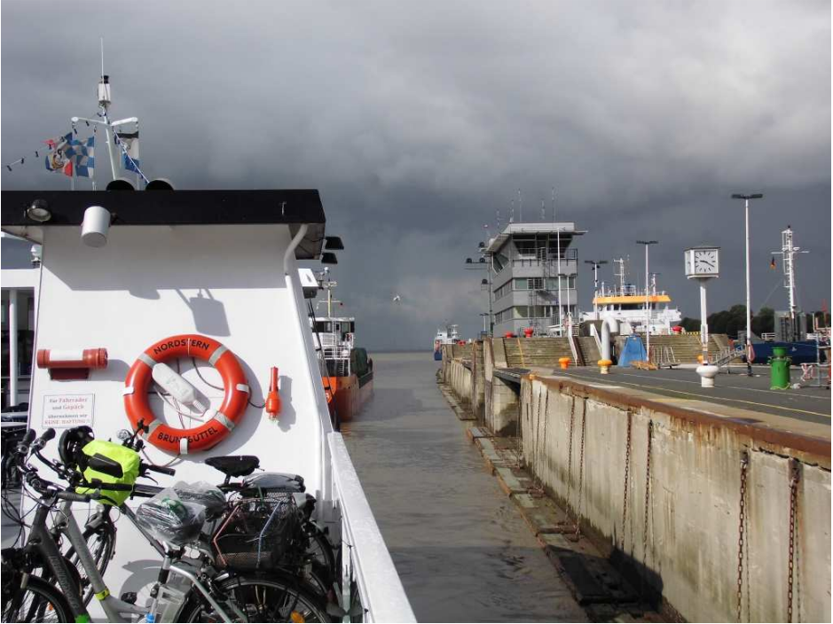
Ausfahrt aus der Kanalschleuse Brunsbüttel
